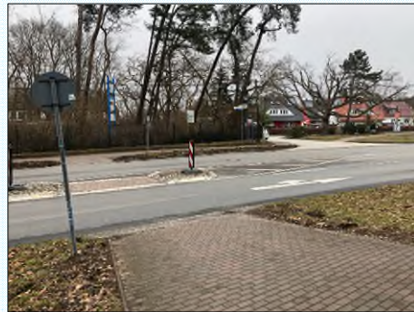
Abb: 2: Bereich „Ribnitzer Straße / Wendenstraße“
