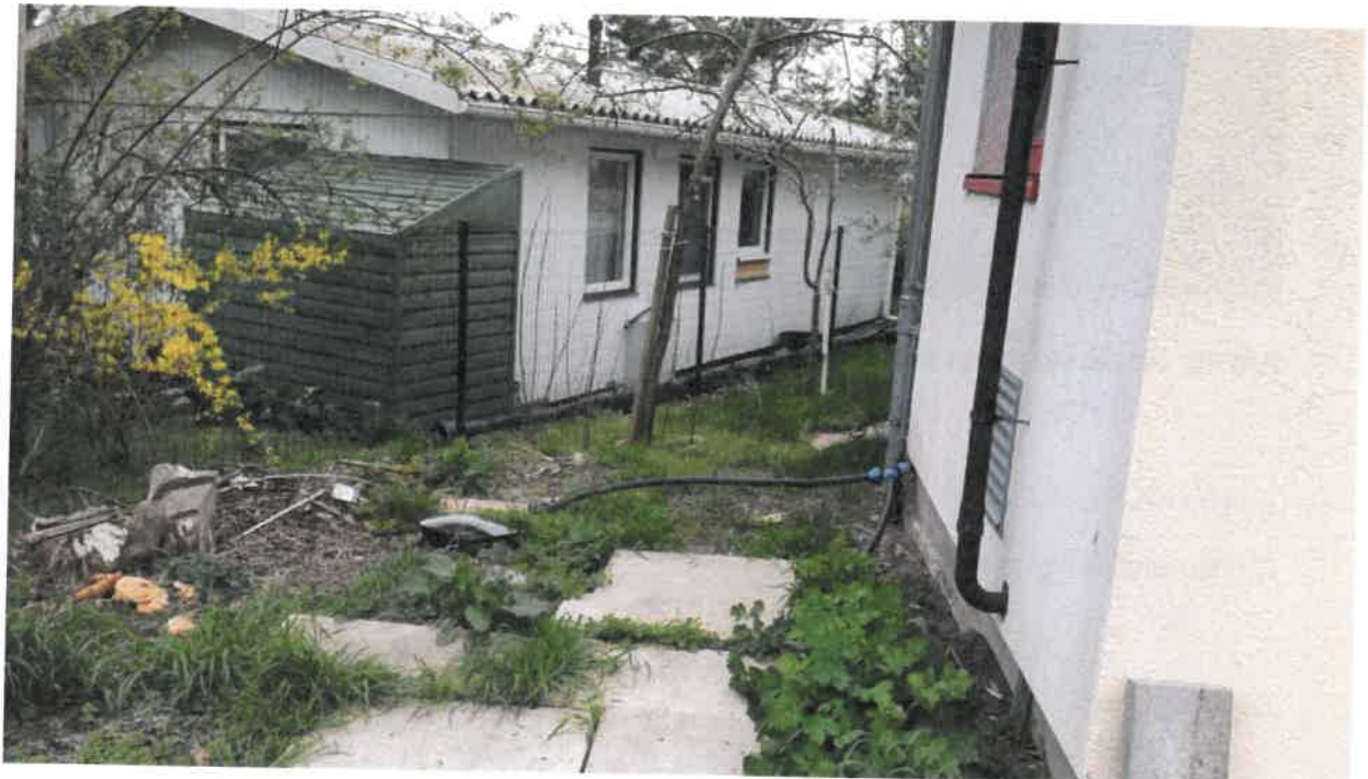
Bild 41: Sicherung abrutschendes Gelände auf der Süd-West-Seite mit Noppenbahnen
