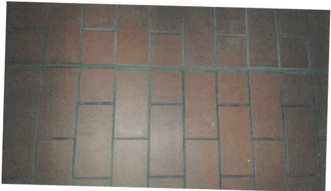
Bild 25: schadhafte Fliesenfugen
