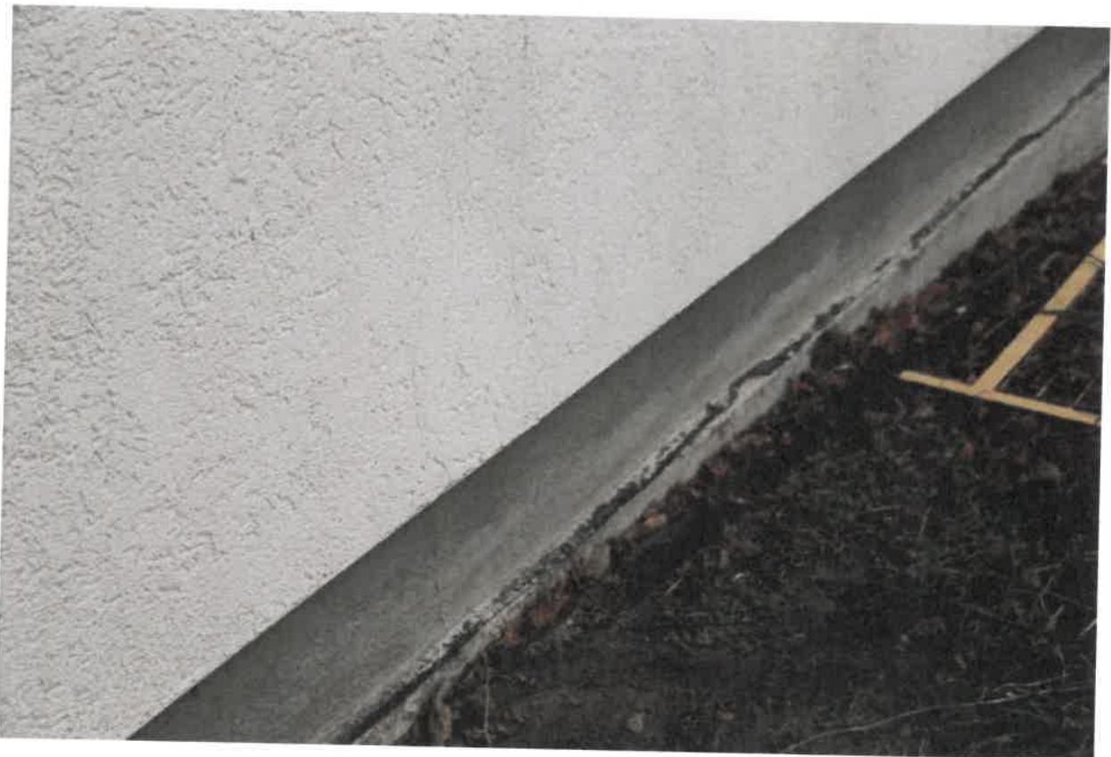
Bild 10: Nord-West-Ansicht – frei liegende Abdichtung
