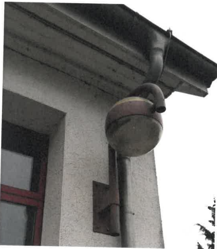
Bild 14: Süd-Ost-Ansicht – vertikaler Riss an Ringanker vertikal
