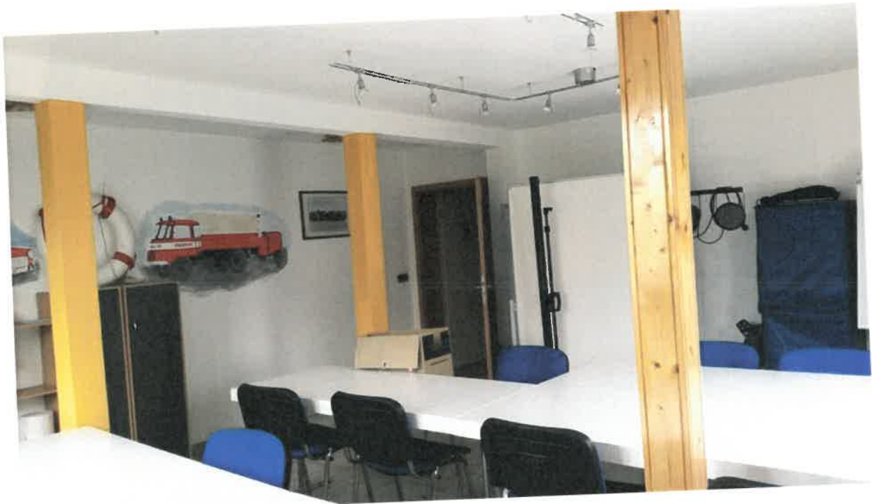
Bild 34: mit Holz bekleidete Stahlstütze (rechts im Bild) und Holzstützen mit Holz bekleidet
