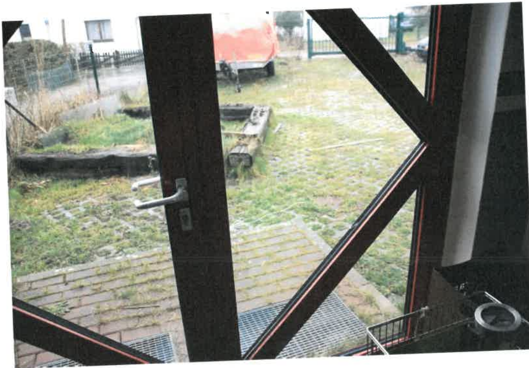
Bild 30: Risse in der Türverglasung
