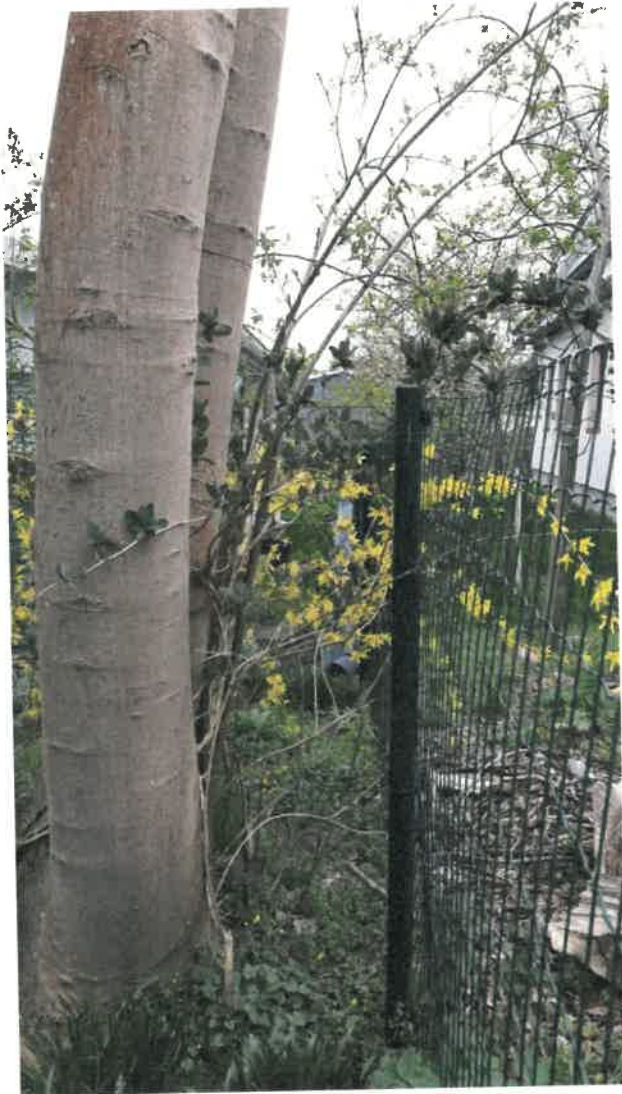
Bild 42: Sicherung abrutschendes Gelände auf der Süd-West-Seite durch Zaun mit Noppenbahnen
