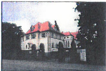
Gebäude des Reha-Zentrums, Rostocker Straße 1
